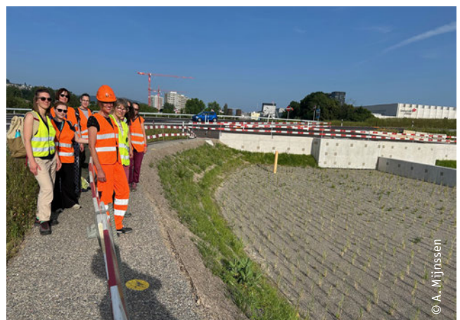
Besichtigung der Strassenabwasserbehandlungsanlage SABA Grünau in Zürich
